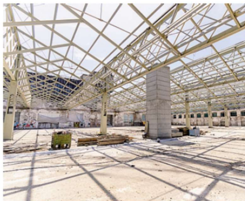
La ristrutturazione in corso dell'ex Linificio in piazzale Forni a Lodi
